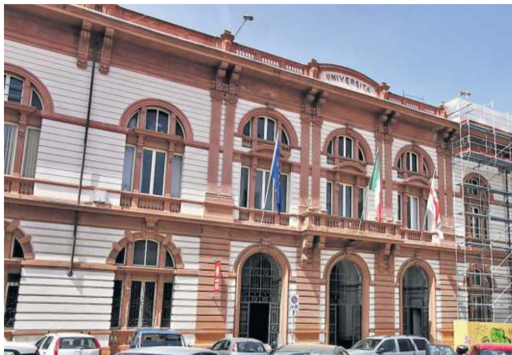
La sede centrale dell’Ateneo sassarese in piazza Università
